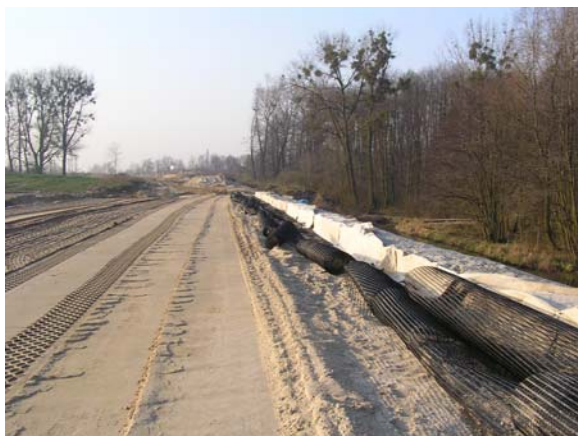
Nasyp drogowy zbrojony geosiatką i skarpa umocniona gabionami [Śrem, Skanska]
