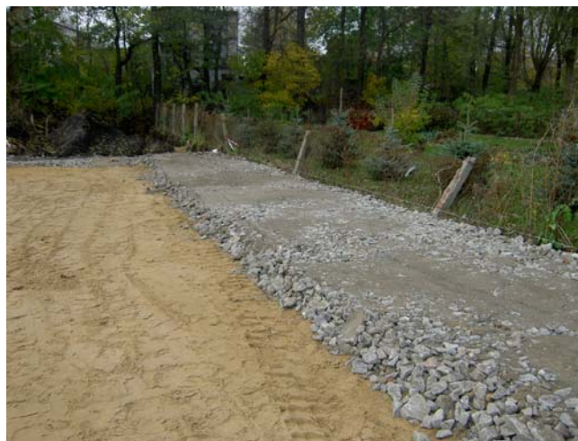
Częściowa wymiana gruntów [Mogilno - Quarto-Sys Spółka z o.o]
