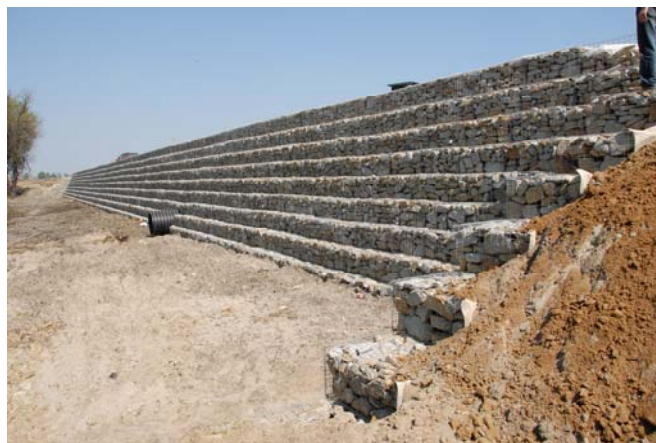
Nasyp drogowy zbrojony geosiatką i skarpa umocniona gabionami [Śrem, Skanska]
