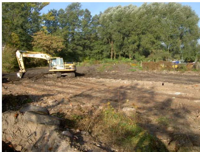
Częściowa wymiana gruntów [Mogilno - Quarto-Sys Spółka z o.o]
