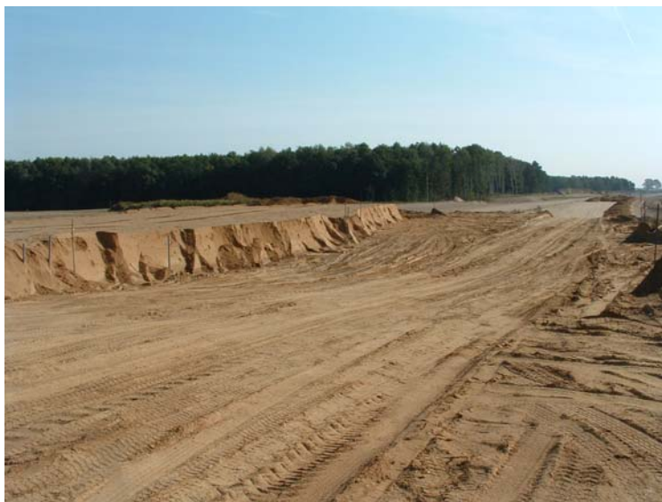
Konsolidacja nasypem przeciążającym [A2 - NCC]
