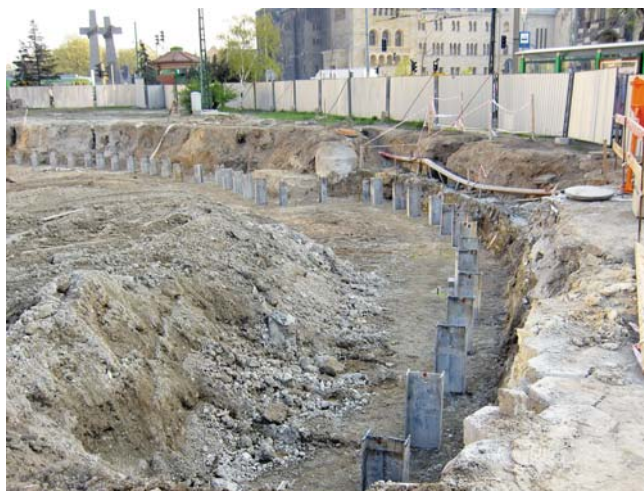
Fot. 2. Palisada przygotowana do wykonania oczepu żelbetowego
